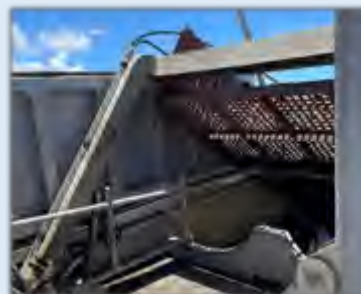
油污回收及過濾作業
