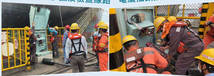
調整配電盤參數及檢查線路 電纜插頭插入岸電箱插座
