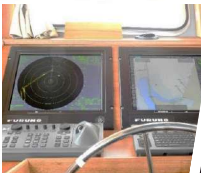
麥寮海洋號內部控制室(1)
