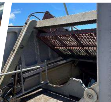
油污回收及過濾作業
