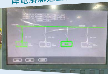
岸電解聯退出供電系統
